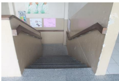
Figura 01: Única escada para acessar o segundo pavimento da E.E.F. Paquetá. Fonte: Acervo pessoal. Data: 31 jul. 2014.
