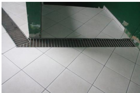
Figura 09: Piso não antiderrapante e barreira em rotas de fluxo na E.E.F. Lions Clube Comp. Oscar Maluche.
