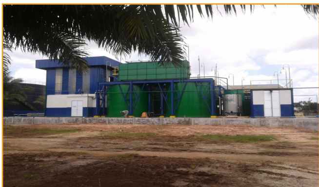
Figura 06: Construção da Estação de Tratamento de Esgoto
