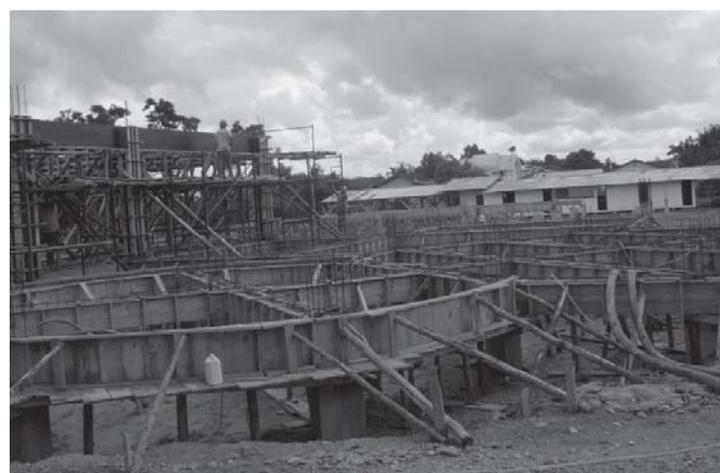
Depois do estaqueamento, colocação de blocos sobre as estacas e vigas de fundação
