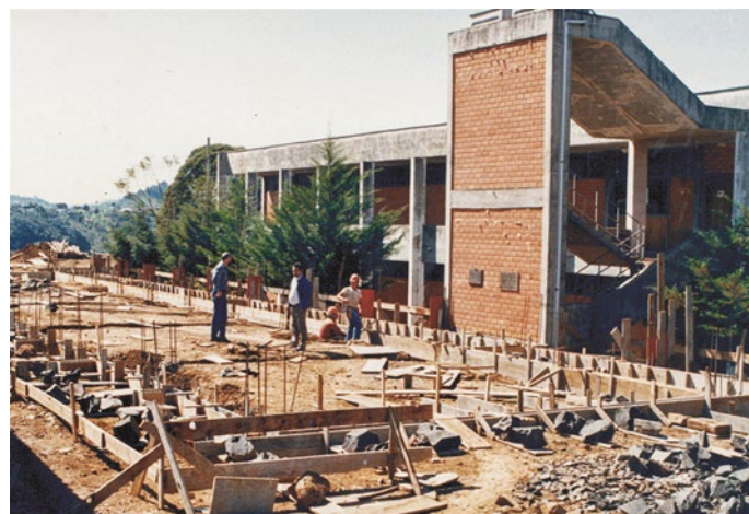
Anos 1990, construção do segundo bloco da Unoesc Joaçaba
