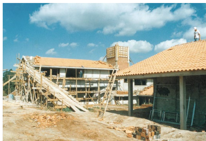
Anos 1990, construção do primeiro bloco da Unoesc Xanxerê
