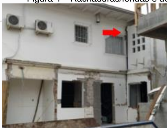
Figura 4 – Rachaduras/fendas e descolamento da parede.
