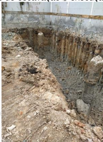
Figura 3 – Início das obras de escavação e execução da cortina de contenção.
