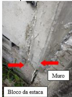
Figura 9 – Muro apoiado no bloco da fundação.
