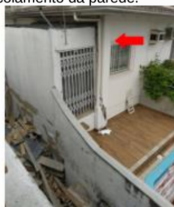
Figura 4 – Rachaduras/fendas e descolamento da parede.
