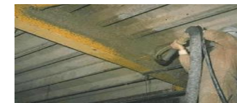
Figura 1: Argamassa projetada.
