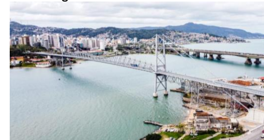
Figura 1 – Ponte Hercílio Luz
