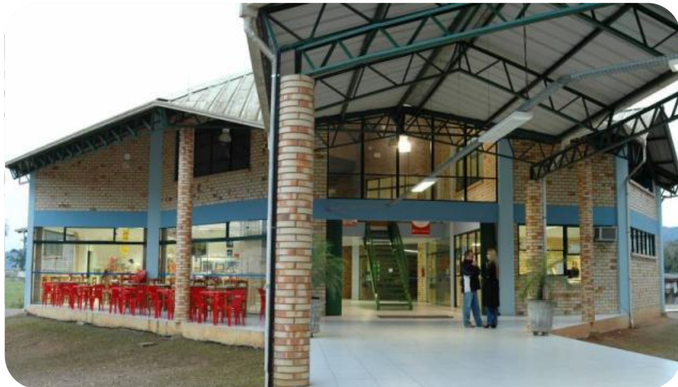
IMAGEM FRONTAL DO CENTRO DE CONVIVÊNCIA – BLOCO B
