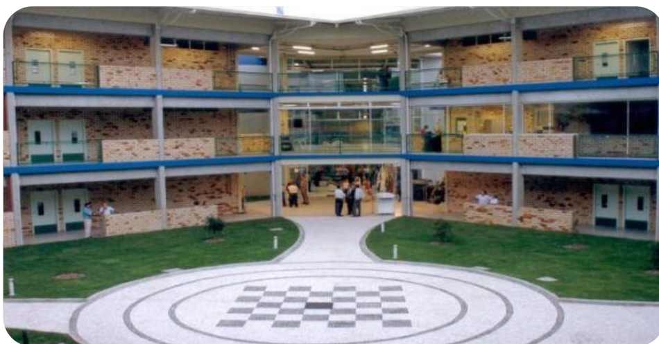
IMAGEM DO PÁTIO DO BLOCO C
