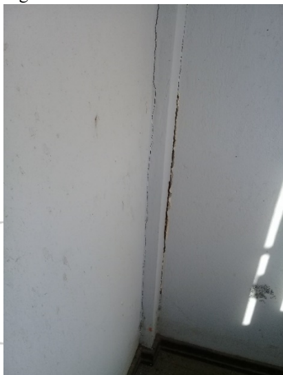
Figura 13 – Rachadura na interface de parede com mocheta
