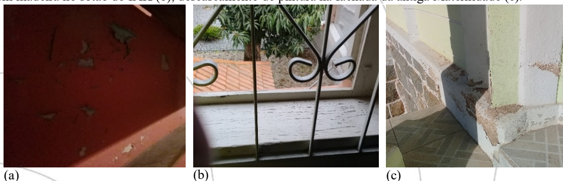
Figura 6 - Descascamento de pintura em reboco no porão da Villa Renaux (a), descascamento de pintura em madeira no sótão do IAK (b), descascamento de pintura na fachada da antiga Maternidade (c).
