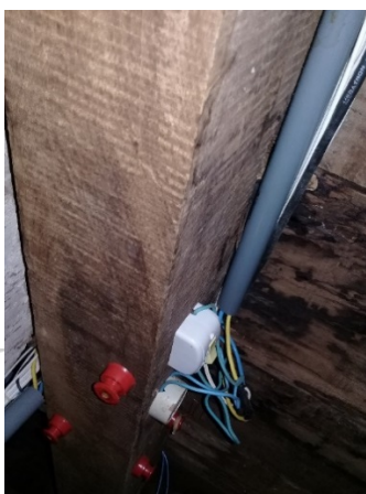
Figura 9 - Instalação elétrica na Villa Renaux fora da norma NBR 5410 (a), caixa de passagem aberta na antiga Maternidade (b), tomada exposta na Antiga maternidade (c)
