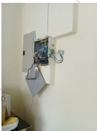
Figura 9 - Instalação elétrica na Villa Renaux fora da norma NBR 5410 (a), caixa de passagem aberta na antiga Maternidade (b), tomada exposta na Antiga maternidade (c)
