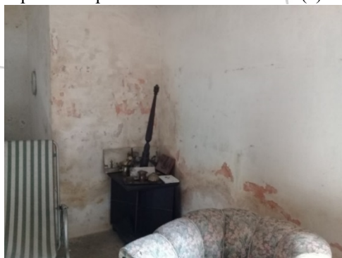
Figura 5 - Presença de umidade no porão em parede em contato lateral com solo (a), presença de umidade no porão em parede de divisória interna (b)
