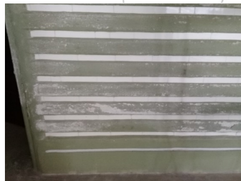
Figura 5 - Presença de umidade no porão em parede em contato lateral com solo (a), presença de umidade no porão em parede de divisória interna (b)
