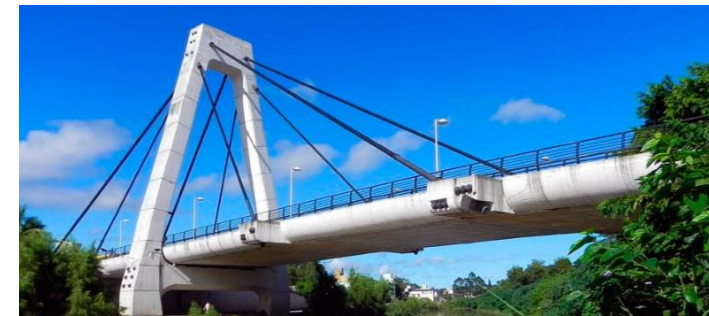
Figura1: Vista Lateral da Ponte Estaiada Irineu Bornhausen.
