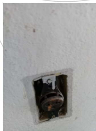
Figura 9 - Instalação elétrica na Villa Renaux fora da norma NBR 5410 (a), caixa de passagem aberta na antiga Maternidade (b), tomada exposta na Antiga maternidade (c)
