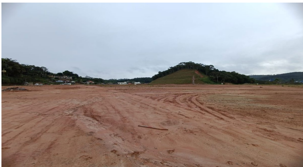
Figura 2 - Terraplenagem do terreno.
